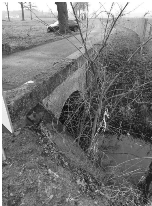
FOT.2 – Widok na konstrukcję istniejącego przepustu od strony wylotu
