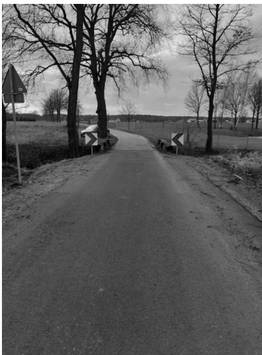
FOT.4 – Widok na przewężenie istniejącej jezdni DP3248P w związku z długością istniejącego przepustu
