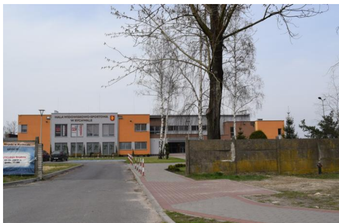
Fot. 2. Hala widowiskowo-sportowa w Rychwale
