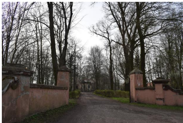
Fot. 30. Brama zespołu dworskiego w Dąbroszynie
