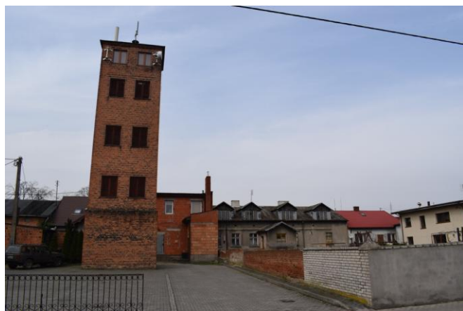
Fot. 6. Wieża remizy strażackiej w Rychwale
