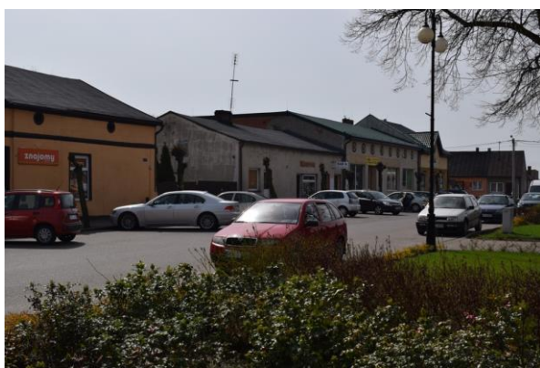
Fot. 22. Zabudowa mieszkaniowo-usługowa tworząca południową pierzeję Rynku w Rychwale
