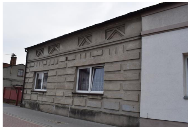
Fot. 8. Powtarzalny motyw na elewacji budynku w historycznej części miasta Rychwał
