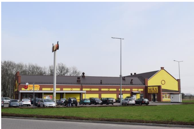
Fot. 7. Zabudowa usług handlu w rejonie drogi krajowej nr 25 w Rychwale
