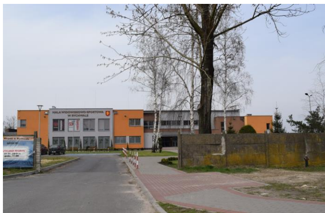
Fot. 2. Hala widowiskowo-sportowa w Rychwale
