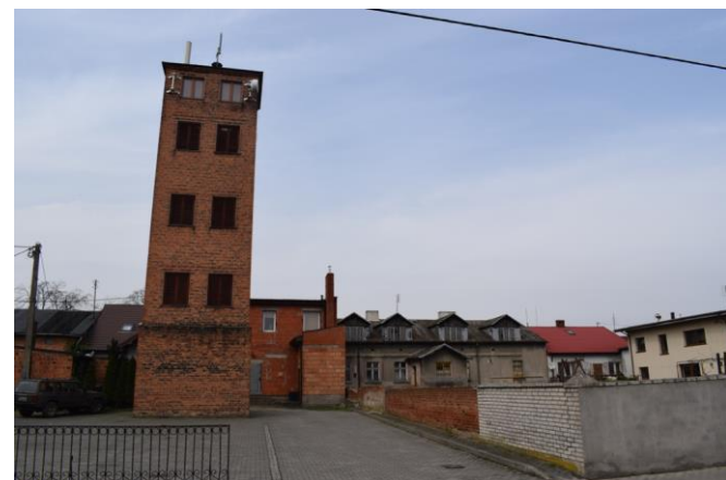
Fot. 6. Wieża remizy strażackiej w Rychwale
