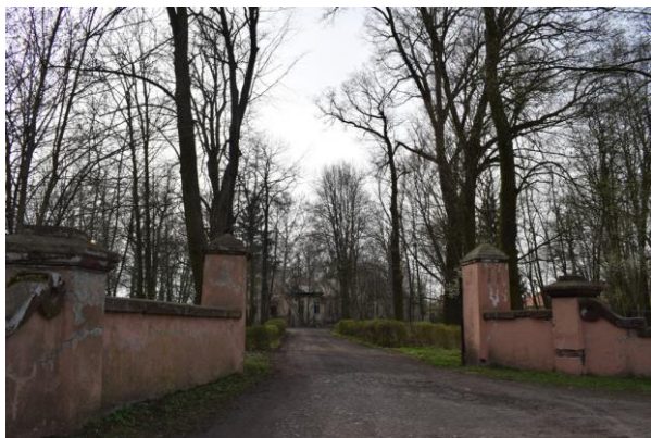
Fot. 30. Brama zespołu dworskiego w Dąbroszynie
